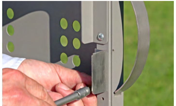
die Magnetschlossfalle verschrauben
