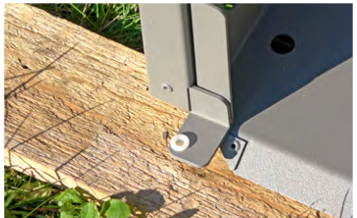
Kunststofflager fest in die Bohrung eindrücken.
